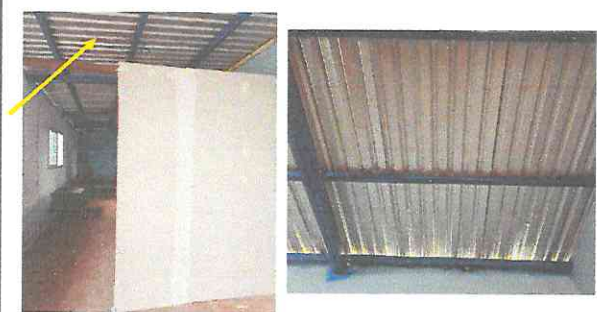
Foto 5: Colocación de lámina troquelada aluzinc en 2 aulas
