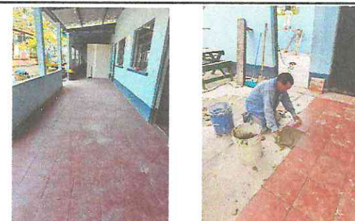
Foto 6: Proceso de colocación de piso cerámico.
