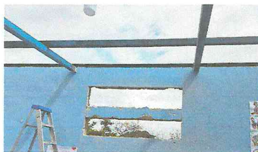
Foto 2: Se retiró block para abrir ventana en un aula para tener mayor ventilación
