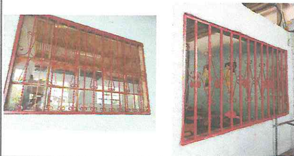
Foto 3: Se retiró la tela metálica dañada, se sustituyó vidrios, se lijó y pintó balcones.
