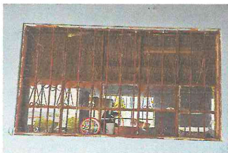
Foto 1: Se retiró la madera de la ventana para sellar con block
